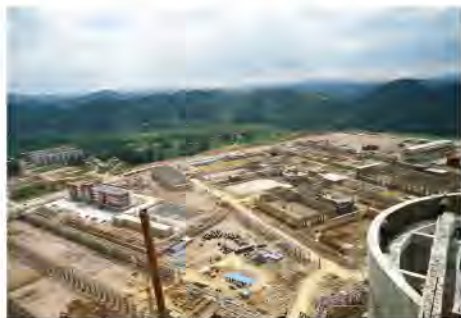
贵州公司-生产管理部-杨宏海：建设中的贵州项目
